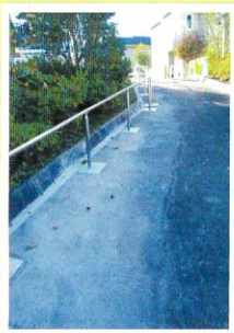
市道の安全手すり設置
