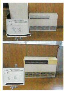
三里塚共同利用施設空調整備
