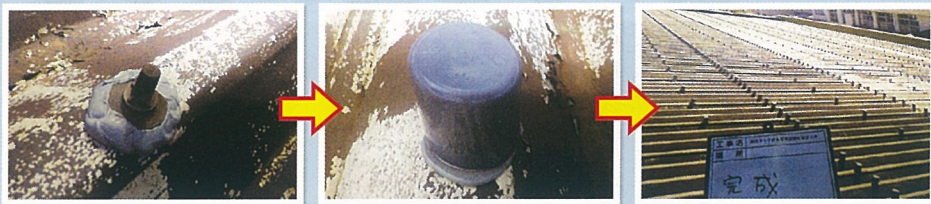
体育館屋根の留め具、全2600カ所のコーキング、キャップ施工しました
